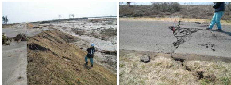
名取川左岸0.8k付近 仙台市若林区日辺地先 津波により堤防法面崩壊 名取川左岸2.8k付近 仙台市若林区今泉地先 地震により天端横断クラック
