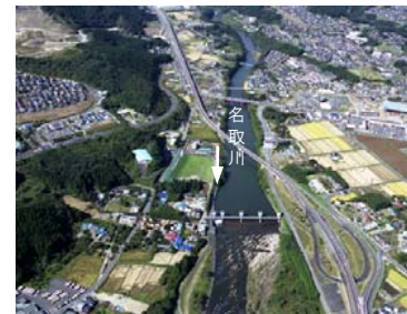
名取川頭首工(S60改築)
