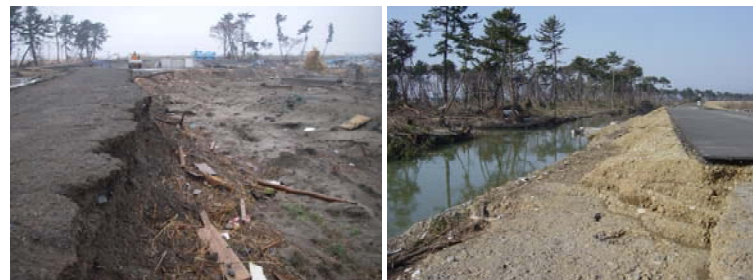
名取川左岸0.0k付近 仙台市若林区藤塚地先 津波により堤防決壊 名取川左岸0.0k付近 仙台市若林区藤塚地先 津波により堤防決壊
