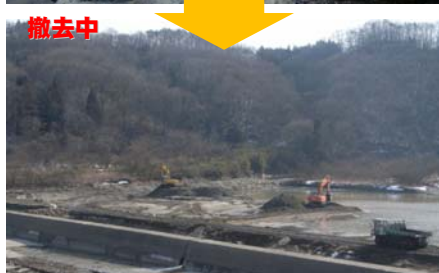
土砂撤去の状況(貯砂ダム)
