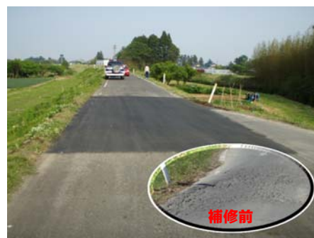
広瀬川堤防天端舗装状況
