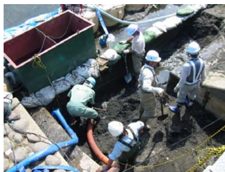
取水ポンプ場土砂撤去作業
