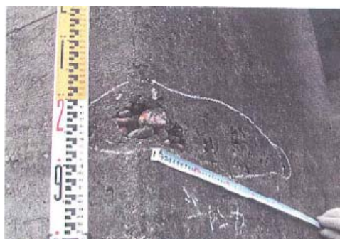
門柱の破損
