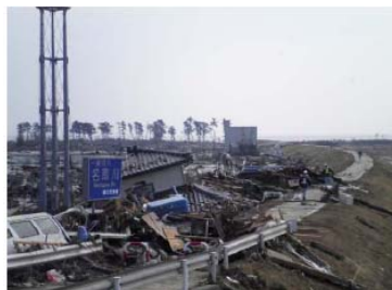
被災状況 (河口から左岸2.0k付近、 仙台市若林区日辺地先)
