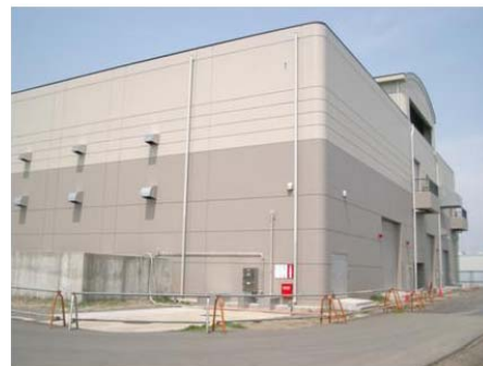
長町第一ポンプ場 (仙台市下水道)
