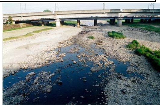
平成 6 年渇水時写真(広瀬川)
