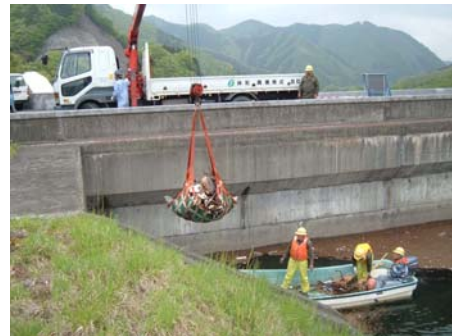
釜房ダム 流木処理
