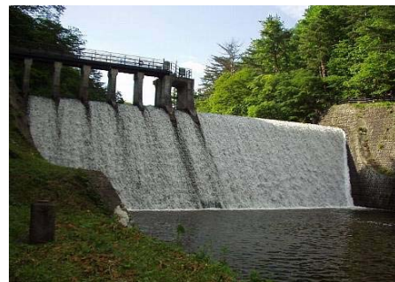
青下第二ダム
