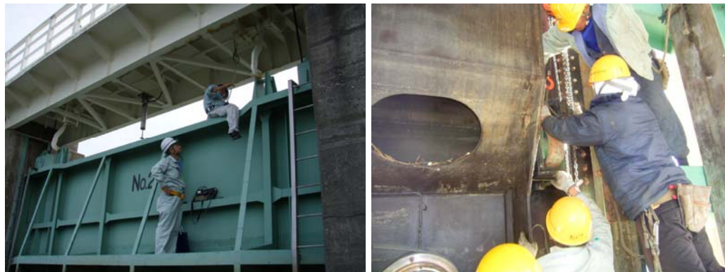
樋門・水門点検状況
