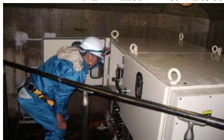
放流設備の点検
