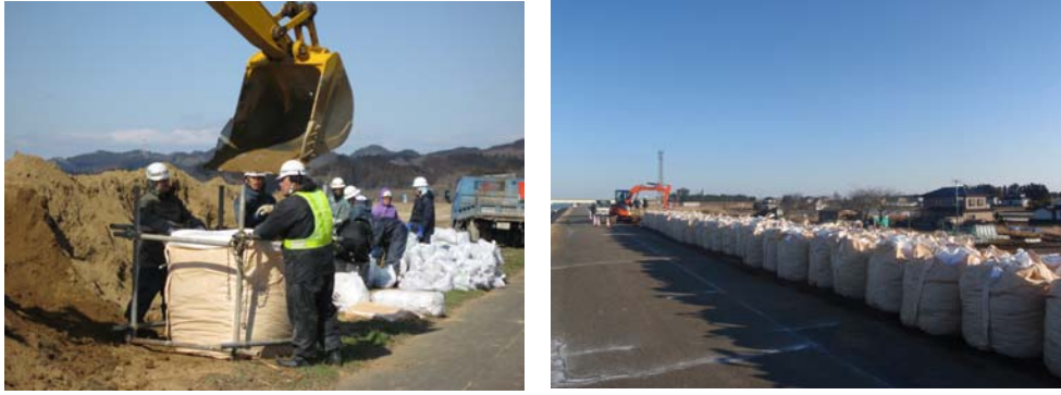
高潮・大雨に備えた大型土のうの設置（名取川右岸 25k 付近、名取市太子堂地先）
