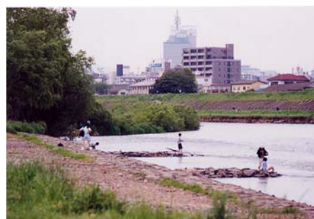
環境及び親水性に配慮した水制工
