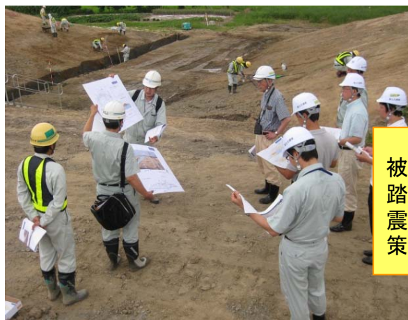
堤防被災の原因調査状況
