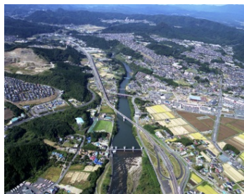
名取川頭首工(S60改築)
