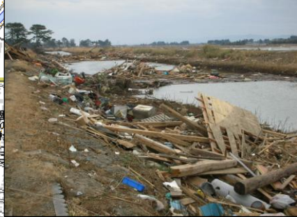
⑤瓦礫による河道閉塞状況
