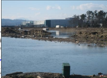
⑦堤防破堤
