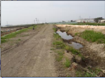
大型土のう仮応急
