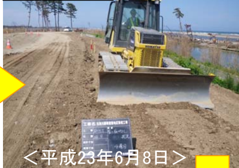
盛土敷均し状況
