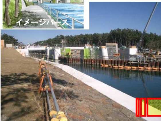
貞山運河水門（平成23年2月16日）
