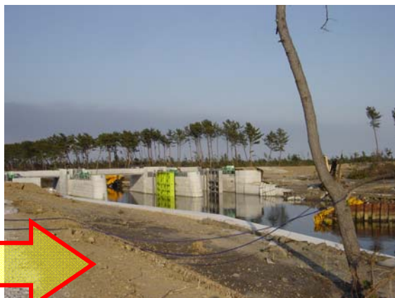
貞山運河水門（平成23年3月13日）
