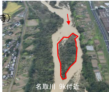
洪水時に流下阻害となる樹木群
