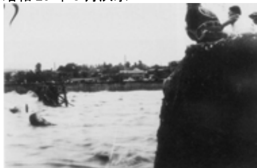
評定河原橋の流出
