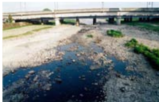
平成 6 年渇水時写真(広瀬川)
