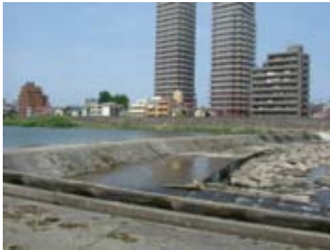
郡山堰における渇水時の状況 【出典：宮城県】
