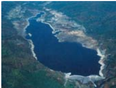
ダム湖周辺の状況
