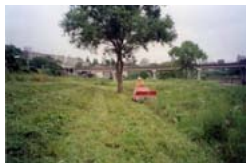
堤防の除草状況
