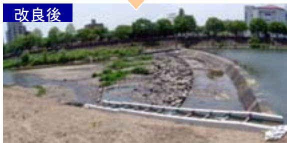
施設を改良した広瀬川郡山堰左岸魚道
