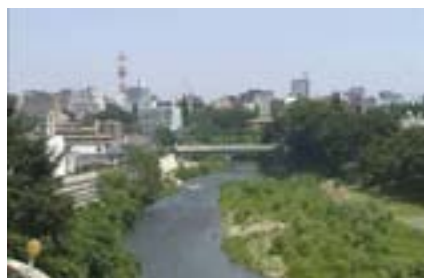
霊屋橋下流 【出典：宮城県】
