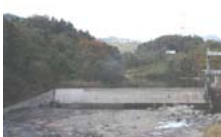
茂庭発電所取水堰（名取川）
