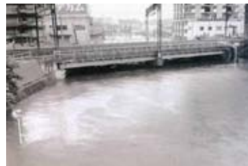
昭和61年8月洪水(JR東北線ガード下の浸水)
