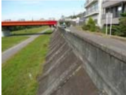
宮沢橋下流の特殊堤
