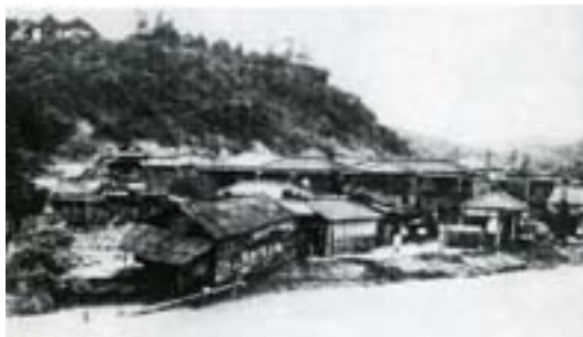
昭和25年8月洪水(広瀬川 あたごばし 愛宕橋上流)
