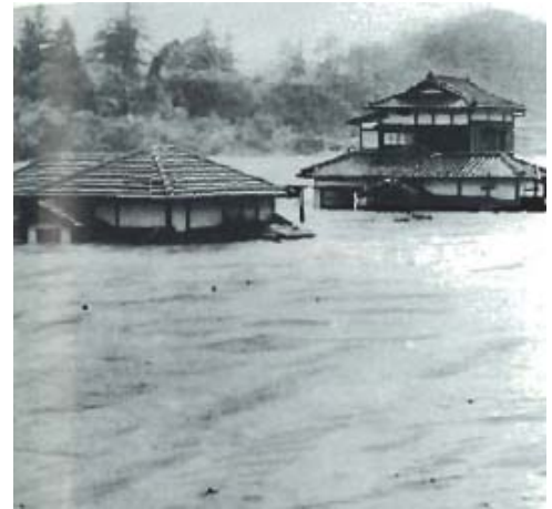
広瀬川堰場付近で洪水に吞まれようとする住宅
