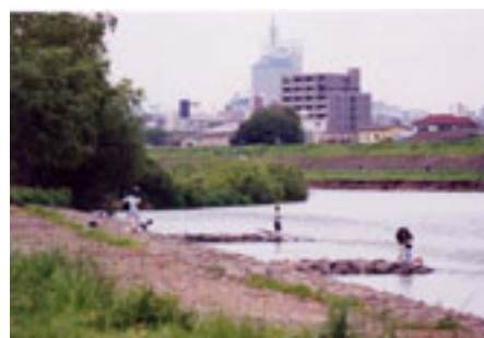
環境及び親水性に配慮した水制工
