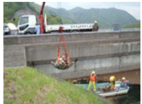
釜房ダム 流木処理
