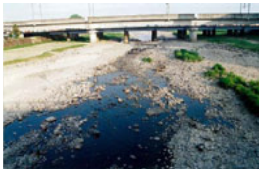
平成6年渇水時写真(広瀬川)
