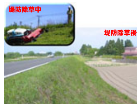
堤防の除草状況
