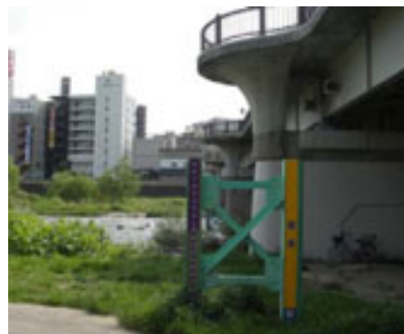
危険水位表示板（広瀬橋）
