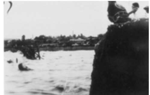
評定河原橋の流出
