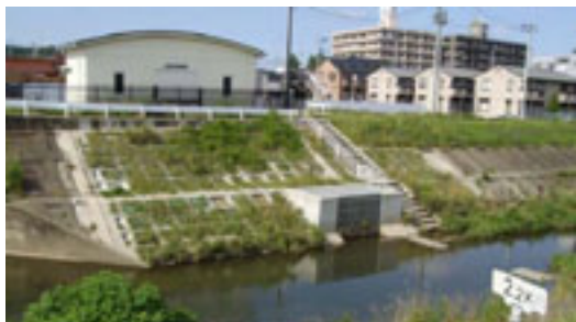
導水施設 取水ポンプ場
