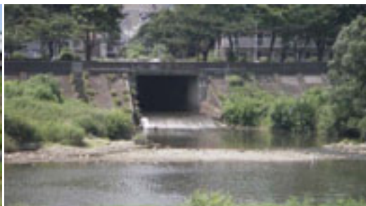
導水状況 広瀬川合流点
