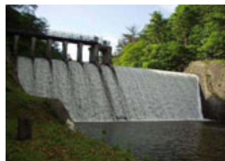
青下第二ダム
