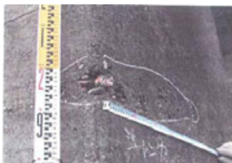
門柱の破損
