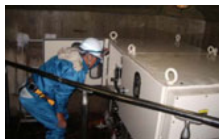
放流設備の点検 出典：釜房ダム管理所資料
