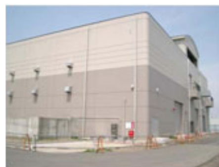
長町第一ポンプ場（仙台市下水道）
