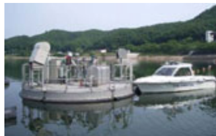
湖上巡視状況 深層曝気施設及び水質自動監視装置の点検 出典：釜房ダム管理所資料
