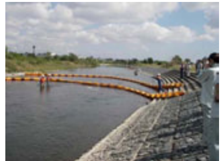
オイルフェンス設置訓練実施状況
