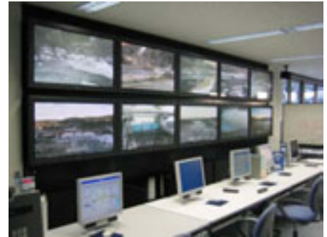
ダム放流設備制御装置
