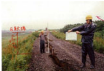
堤防の亀裂・沈下
