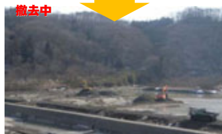
土砂撤去の状況（貯砂ダム）
