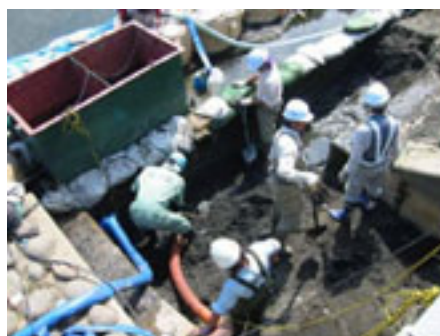
取水ポンプ場土砂撤去作業
