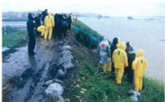
S61.8洪水 藤塚地区法崩れの状況
