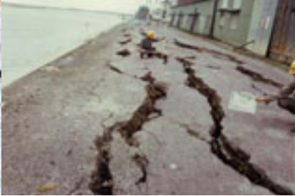
護岸背後の亀裂状況
