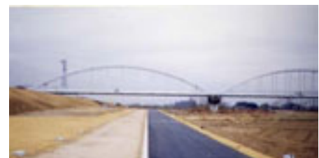
緊急河川敷道路
