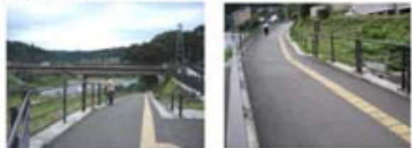
牛越橋から八幡地区に接続する 高水敷内の遊歩道及びスロープ
