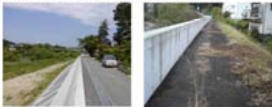
堤防・護岸補修の例(大橋、重屋橋)
