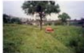
堤防の除草状況
