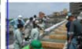
郡山堰の仮設魚道設置 (NPOとの連携事業)
