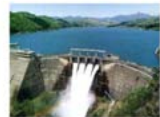
昭和36年に完成した大倉ダム
