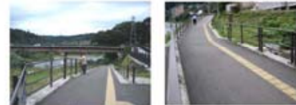
牛越橋から八幡地区に接続する 高水敷内の遊歩道及びスロープ 牛越橋下流左岸のスロープ 【出典 宮城県】
