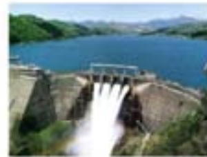
昭和36年に完成した大倉ダム
