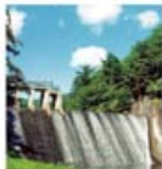
青下ダム貯水池 【出典: 仙台市HP】
