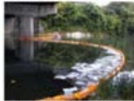
オイルフェンス設置状況
