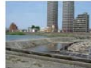
郡山堰における洪水時の状況
