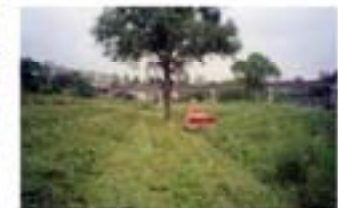
堤防の除草状況 【出典 宮城県】
