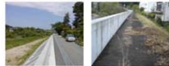
堤防・護岸補修の例(大橋、重屋橋) 【出典 宮城県】
