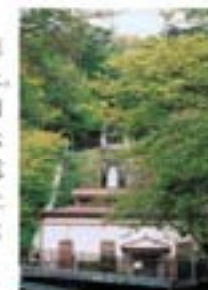
三居沢発電所 【出典: 仙台市】
