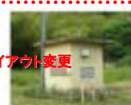
治水機設置の様子
