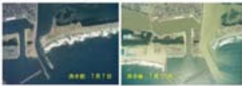
図 5.2.2 平成 14 年 7 月治水機設置の河川設備の変化
