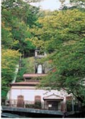
三層沢発電所
