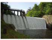
青下第二ダム
