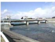
名取川樋首工
