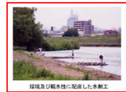
環境及び親水性に配慮した水制工
