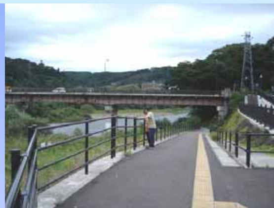
牛越橋下流左岸のスロープ
