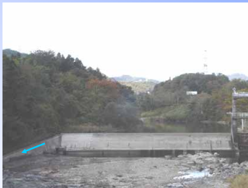
(名取川 赤石橋上流茂庭発電所取水堰)
