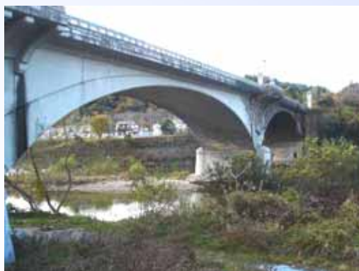
青葉山と市街地を結ぶ大橋
