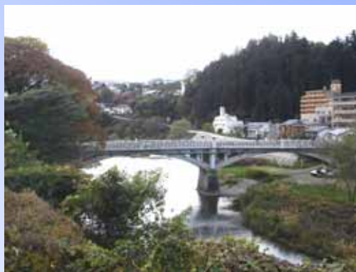
昭和10年に架けられた霊屋橋
