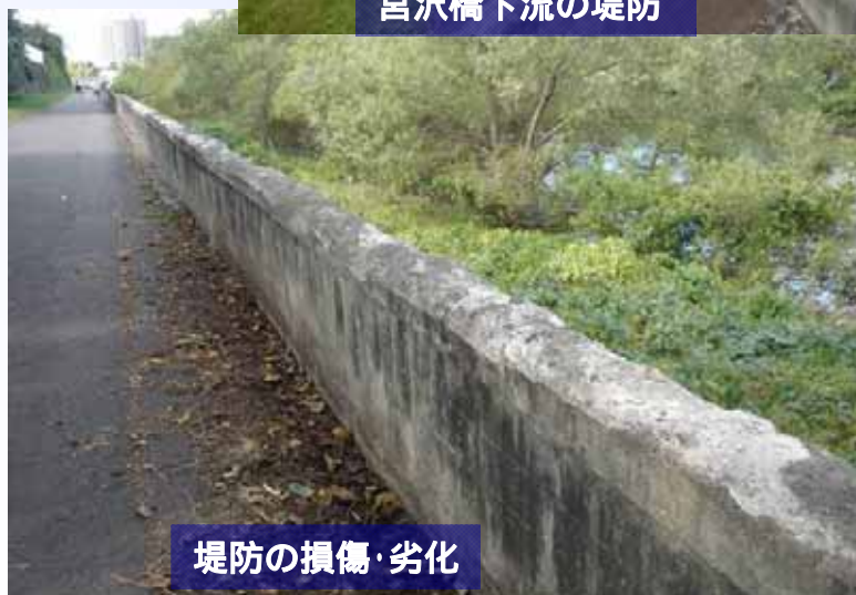
宮沢橋下流の堤防
