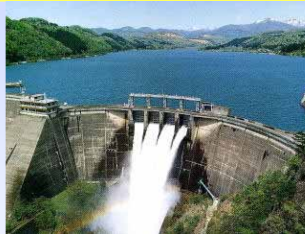
大倉ダムの状況
