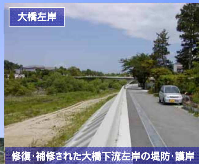
堤防・護岸補修の例(大橋、霊屋橋)
