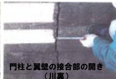
門柱と翼壁の接合部の開き（川裏）
