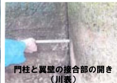
門柱と翼壁の接合部の開き（川表）
