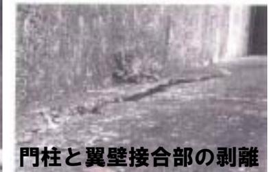
門柱と翼壁接合部の剥離
