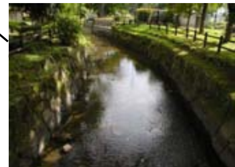
【六郷堀・七郷堀】江戸時代に開削された農業用水路であり、防災・生活用水としても重要だった。現在もかんがい用水路として利用
