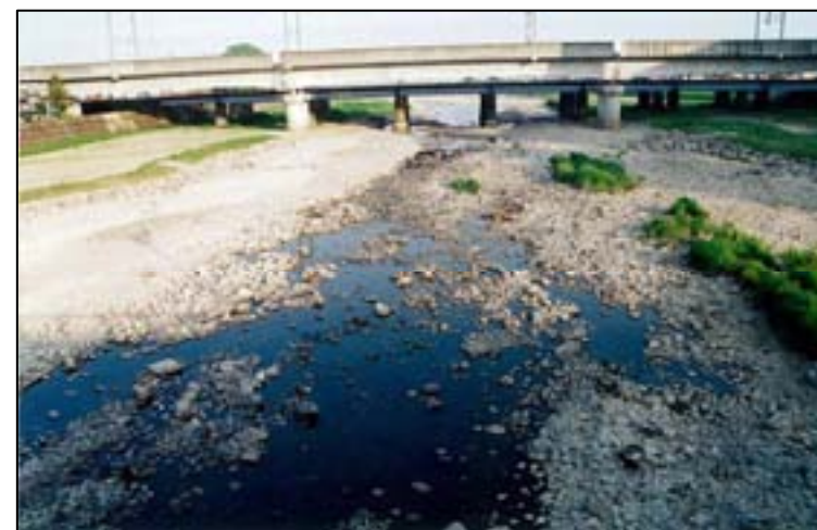
▲広瀬橋下流(撮影日:平成6年8月23日)
