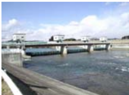
【名取川頭首工】藩政時代に造られた六郷堰が、アイオン台風(S23.9)による被災により昭和26年に新築された後、昭和60年に名取川頭首工として改築
