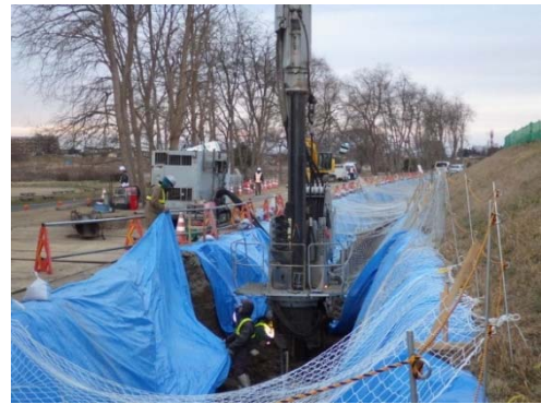
施工状況(長町地区)
