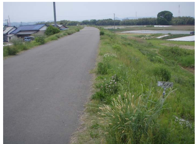
堤防天端の保護対策(例:名取川右岸 5.4k)
