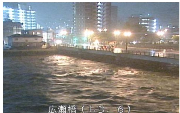
広瀬橋の状況（平成 27 年 9 月洪水）
