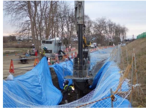
施工状況(長町地区)
