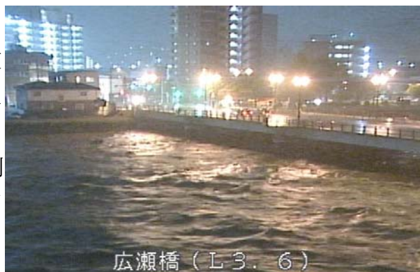
広瀬橋の状況（平成 27 年 9 月洪水）
