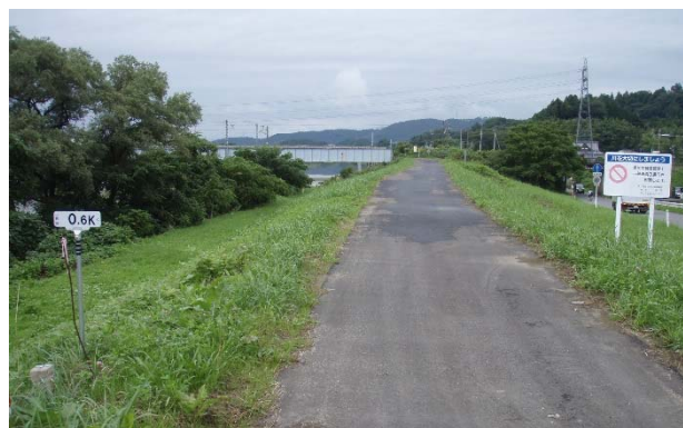
堤防天端の保護対策(例:阿武隈川支川 白石川 左岸 0.6k)
