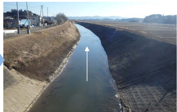
土砂撤去（流下能力の改善）
