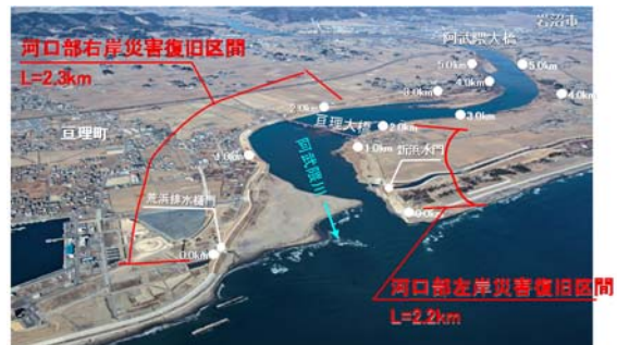
復旧状況斜め写真（平成 29 年 2 月 28 日撮影）
