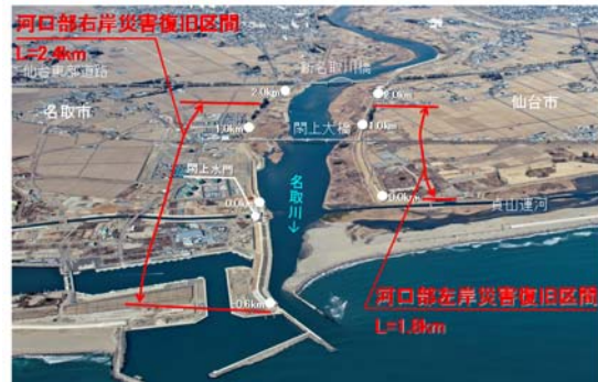
復旧状況斜め写真（平成 29 年 2 月 25 日撮影）
