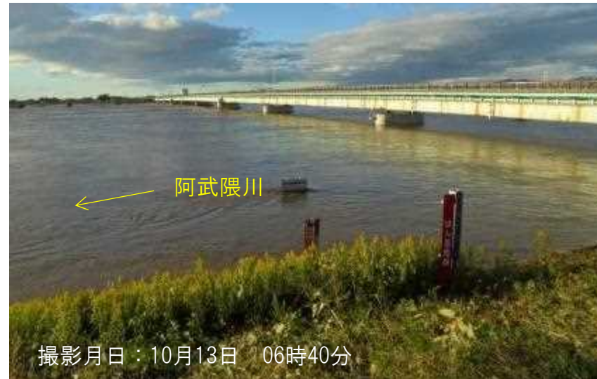
阿武隈川下流 阿武隈橋(8.1k付近) 宮城県岩沼市阿武隈地先
