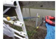
土手に手すりと階段を設置
