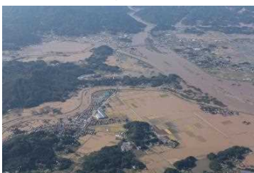
2019 令和元年東日本台風 (5)
