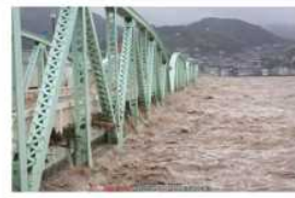
熊野大橋にまで押し寄せた洪水
