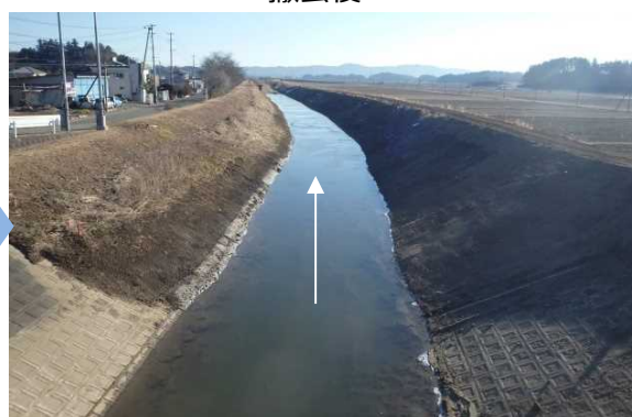
土砂撤去（流下能力の改善）
