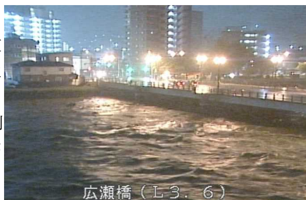
広瀬橋 (L3.6) 広瀬橋の状況 (平成 27 年 9 月洪水)
