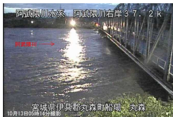
丸森橋の状況 (令和元年 10 月洪水)
