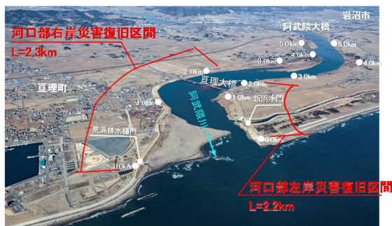
復旧状況斜め写真（平成29年2月28日撮影）
