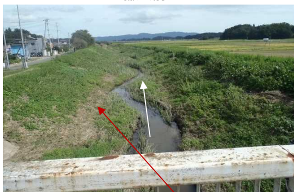
堆積土砂（流下能力の阻害）
