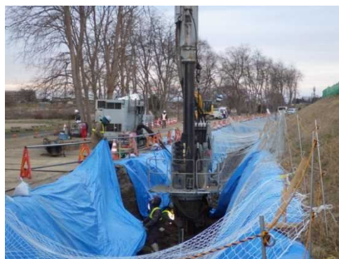
施工状況(長町地区)
