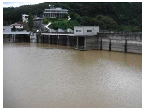
10月13日7:00時点の貯水位状況
