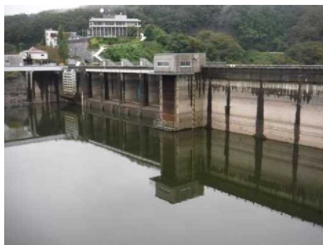
10月11日15:00時点の貯水位状況
