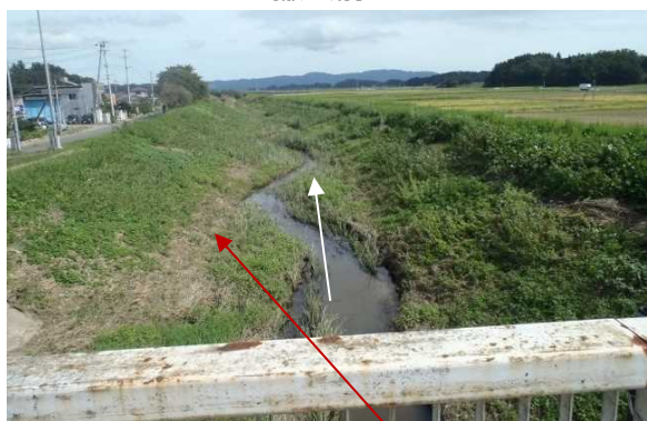
堆積土砂（流下能力の阻害）
