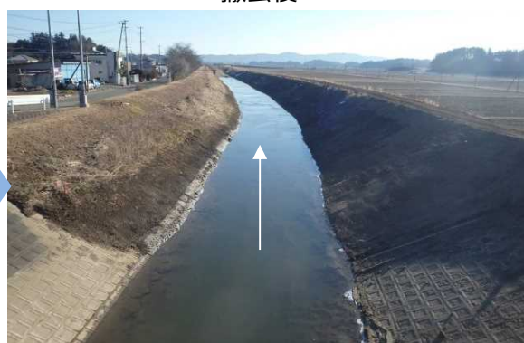
土砂撤去（流下能力の改善）
