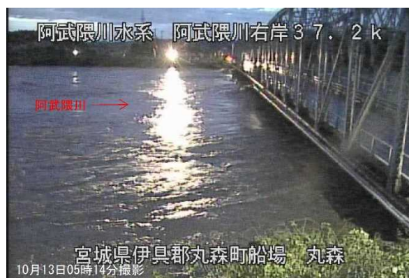
丸森橋の状況（令和元年 10 月洪水）
