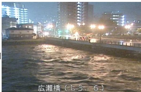
広瀬橋の状況（平成 27 年 9 月洪水）
