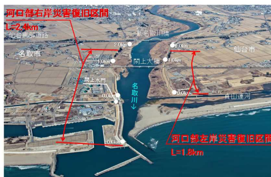
復旧状況斜め写真（平成29年2月25日撮影）
