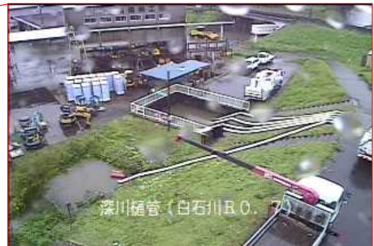
▲排水ポンプ車設置状況
