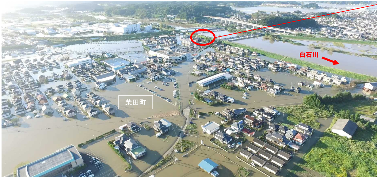
▲柴田町下名生地内の浸水状況（10月13日撮影）
