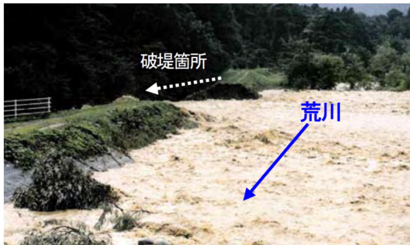
決壊した支川荒川の堤防
