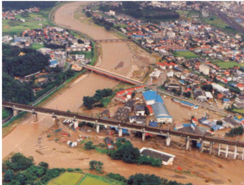
決壊した支川堀川が合流する白河市の浸水状況
