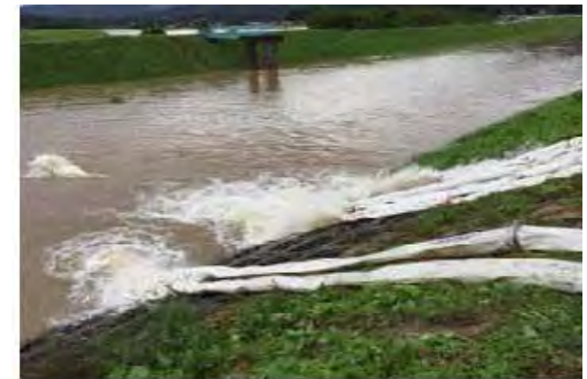
内川への排水
