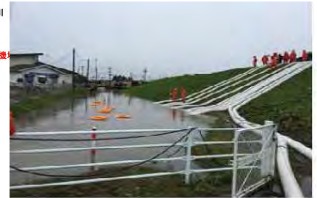
丸森町雨水調整池
