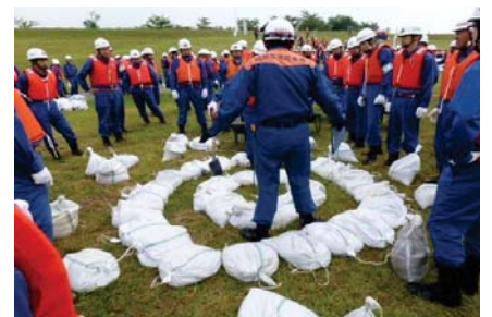
《水防工法訓練》（水防団参加） 釜段工法を指導している様子 （阿武隈川左岸河川敷） 【平成29年6月25日実施】
