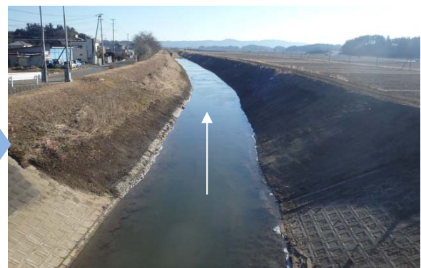
土砂撤去（流下能力の改善）
