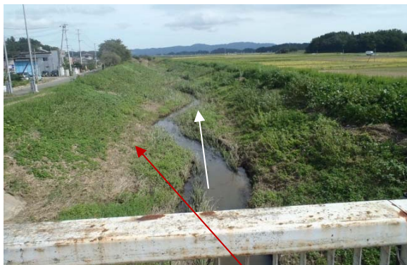
堆積土砂（流下能力の阻害）
