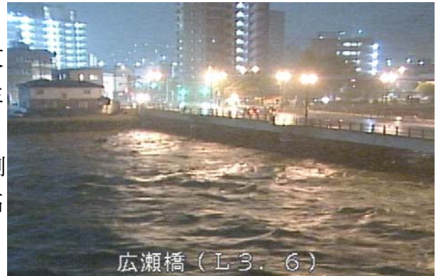
広瀬橋の状況（平成 27 年 9 月洪水）
