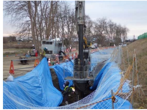
施工状況(長町地区)
