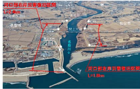
復旧状況斜め写真（平成 29 年 2 月 25 日撮影）
