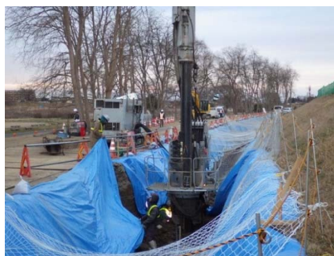
施工状況(長町地区)
