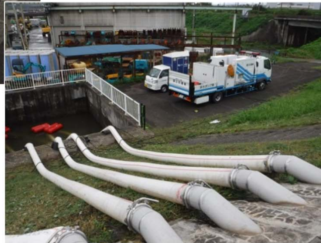
柴田町下名生八剣での内水排除 作業状況（9月11日14時撮影）
