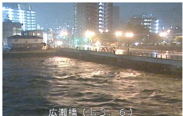
広瀬橋の状況（平成 27 年 9 月洪水）
