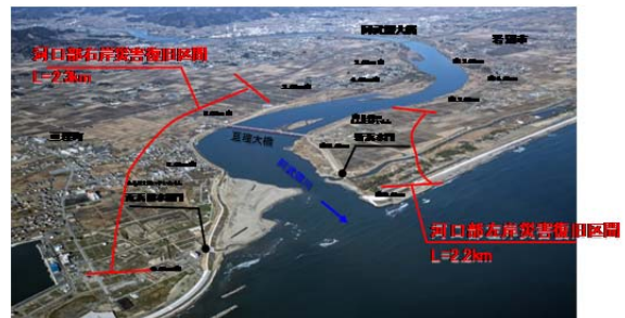
復旧状況斜め写真(平成26年12月8日撮影)
