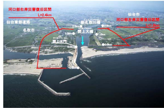
復旧状況斜め写真(平成26年8月24日撮影)
