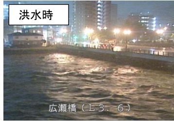
仙台河川国道事務所ホームページによる広瀬橋地点のライブ画像
