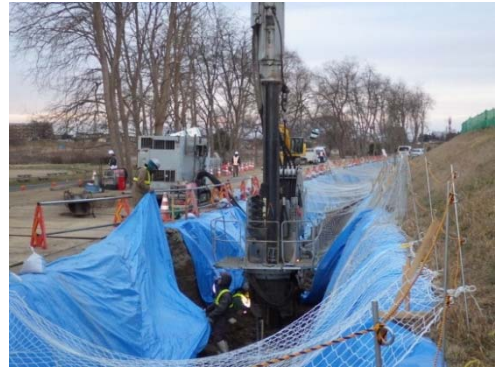
施工状況(長町地区)
