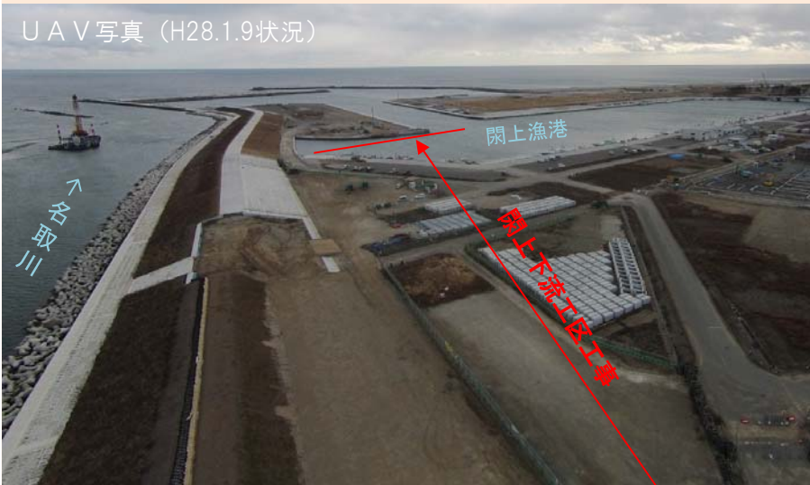
地盤改良工 (パワーブレンダー工法)
