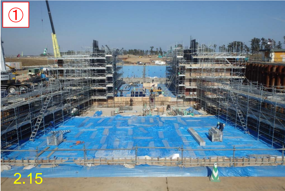
① 水門正面より:鉄筋・足場組立(本体部)
