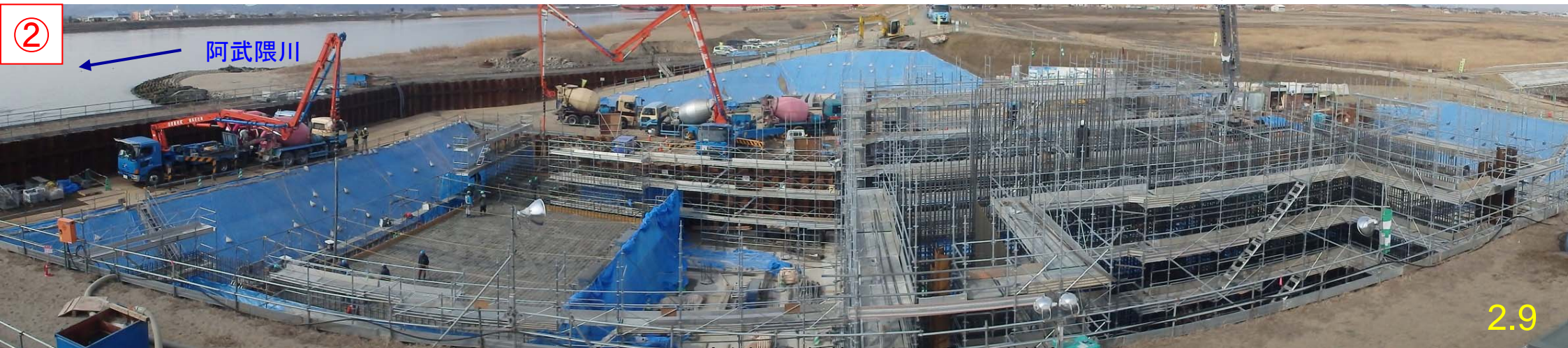
② 下流側から上流を望む:鉄筋・足場組立設(本体部)
