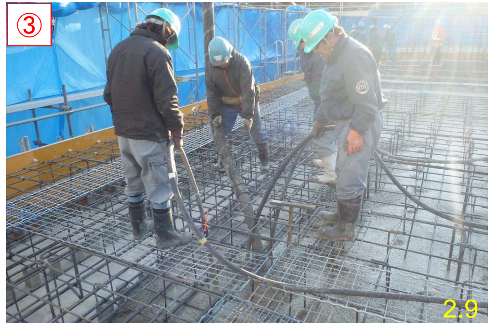
③ コンクリート打設状況
