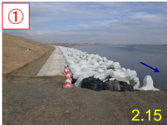
起点より上流側：完成
