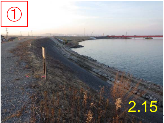
① 起点より上流側：工事用道路造成
