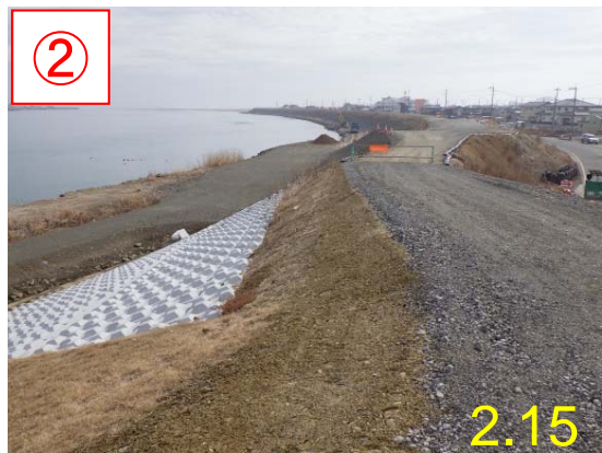
② 終点より下流側：工事用道路造成
