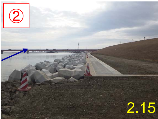
終点より下流側：完成
