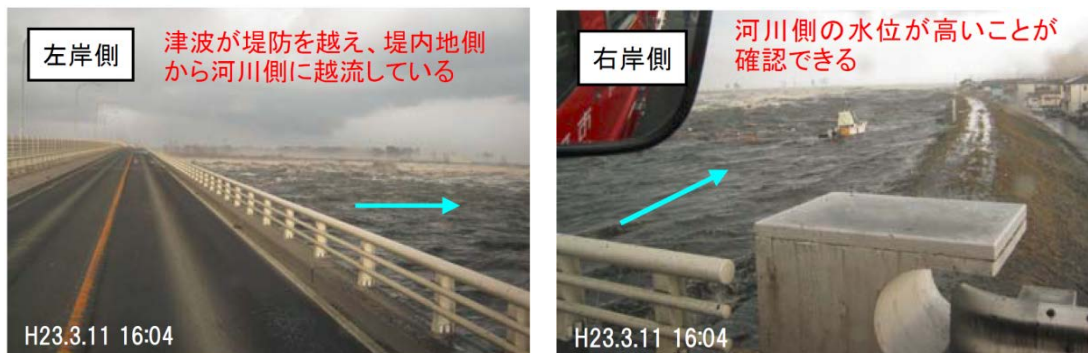
図 3.1.15 堤防越流時の状況 (名取市消防本部 瀬野尾好昭氏提供)
