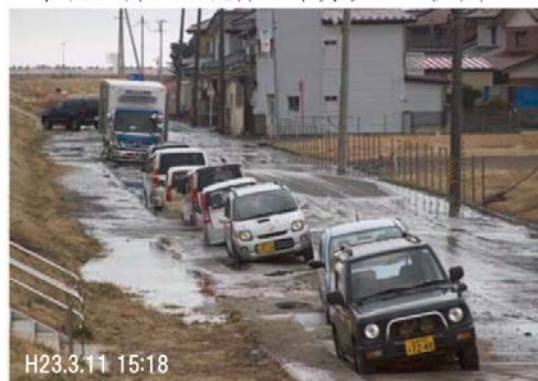
図 3.1.16 堤防裏法尻道路の液状化〔閑上地区〕 (津波来襲直前に撮影：小齊誠進氏提供)
