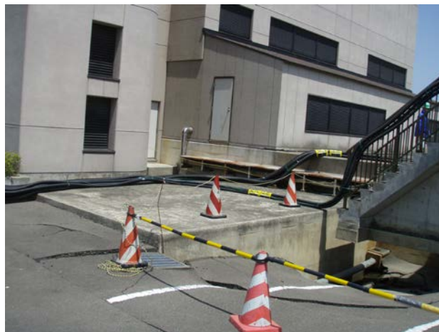
施工後(押分排水機場)
