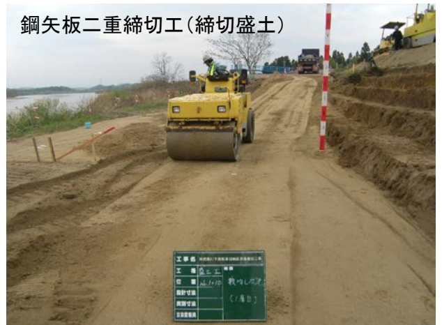
鋼矢板二重締切工(中詰盛土)
