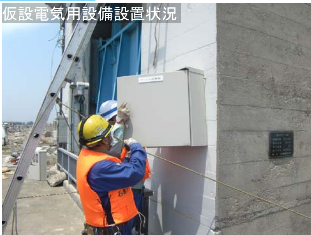
引き込み開閉器盤設置状況
