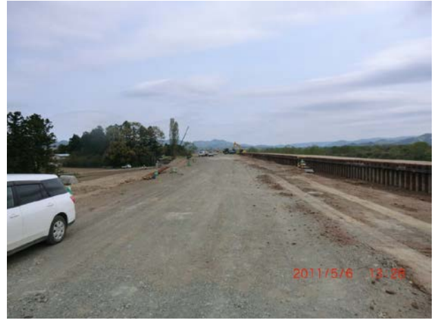
鋼矢板二重締切工 (設置完了)
