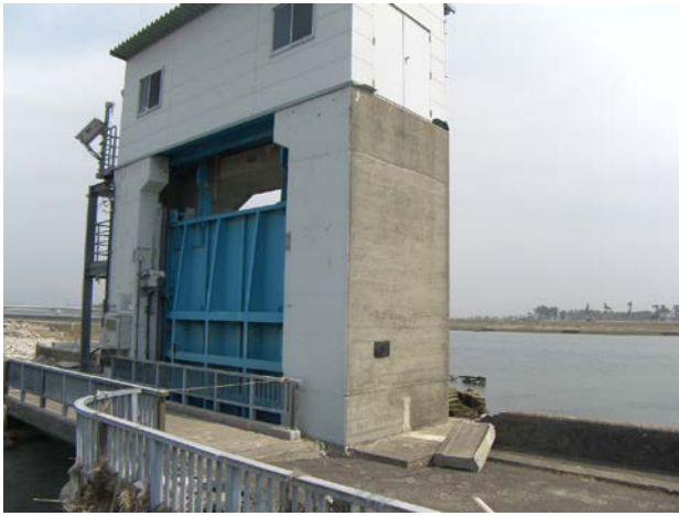
着工前(閉上水門)
