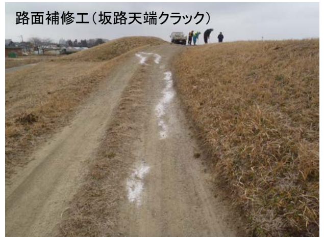
路面補修工(充填状況)
