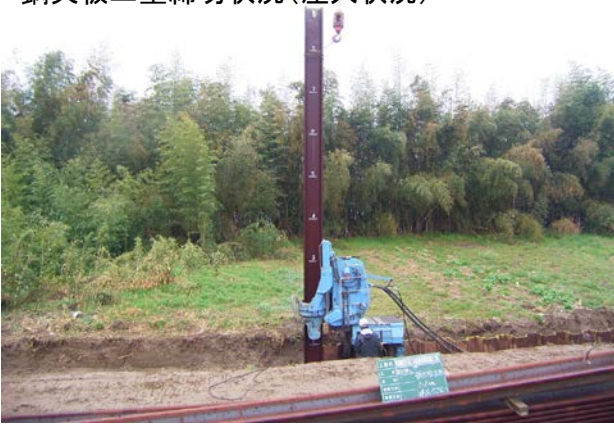
鋼矢板二重締切状況(圧入状況)
