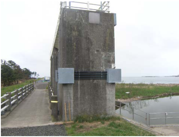
着工前(新浜水門)
