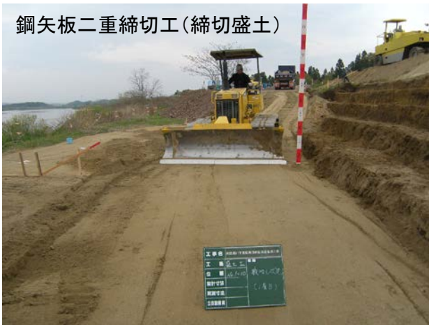
鋼矢板二重締切工(中詰盛土)
