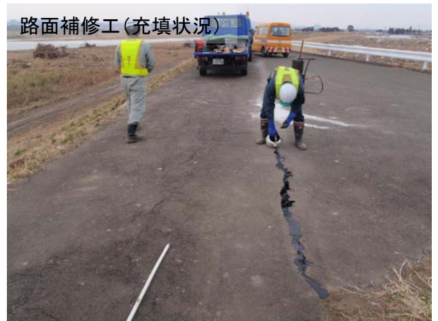
路面補修工(充填完了)
