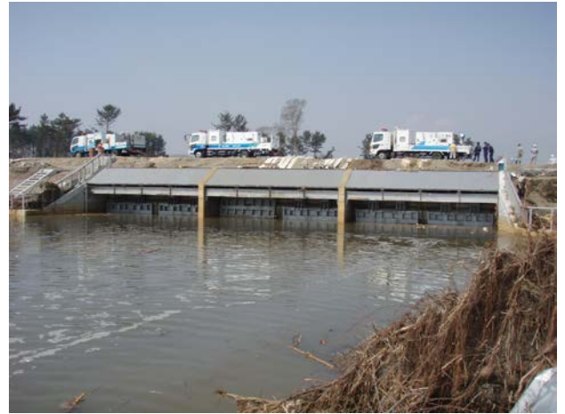
完了後(閉操作)
