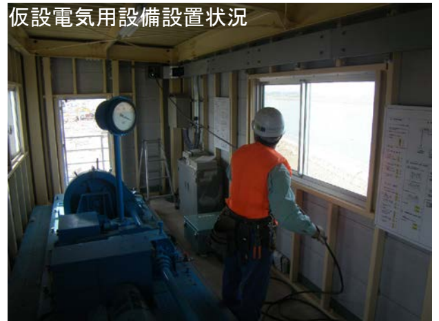
仮設電源での動作確認状況
