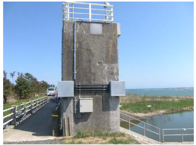
施工後(新浜水門)
