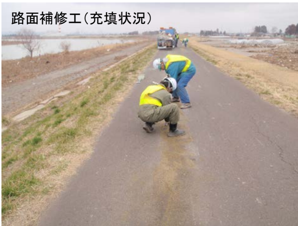
路面補修工(充填状況)
