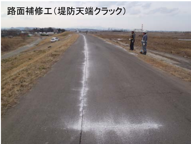
路面補修工(充填状況)
