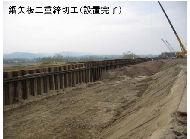
鋼矢板二重締切工 (中詰盛土工)
