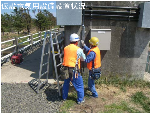
動力切替装置盤設置状況
