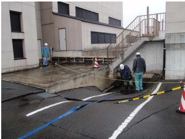
着工前(押分排水機場)
