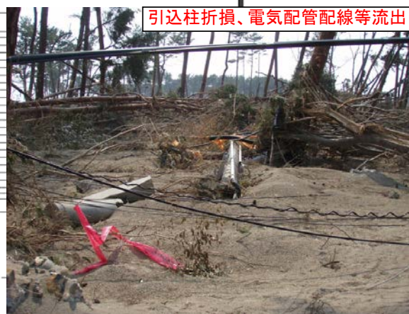
電気配管配線等流出
