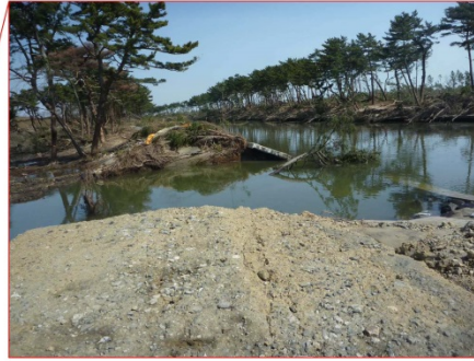
堤防決壊(貞山運河堤防)
