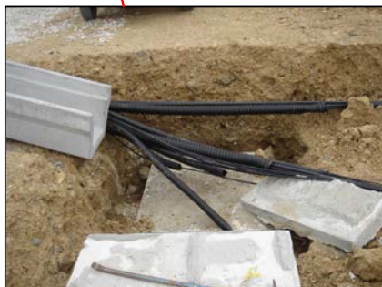
配管破損
