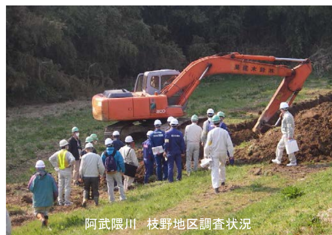
第1回 北上川等堤防復旧技術検討会実施状況
