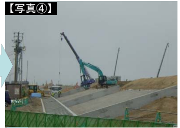
小口止工・隔壁工設置
