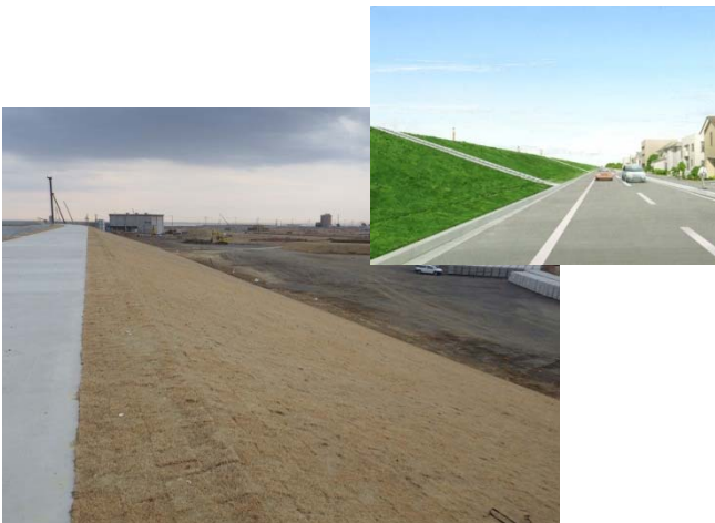
被覆コンクリートブロックへの覆土状況 (右上は、検討時点のイメージパース)
