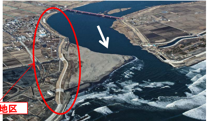
平成29年1月時点 復旧状況
