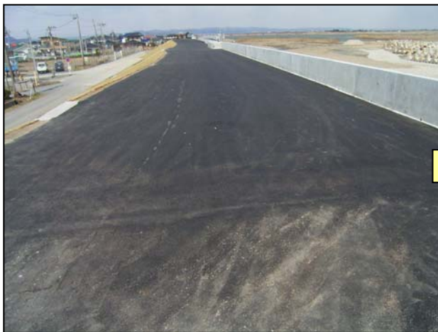
被災前（竣工時） 平成17年時点
