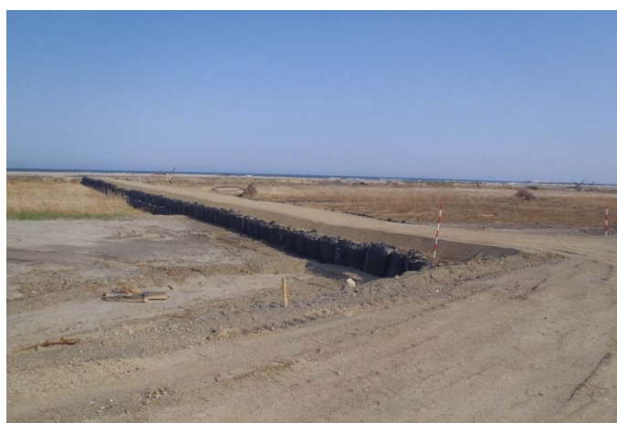
名取川藤塚地区（井土浦川付近）防潮対策
