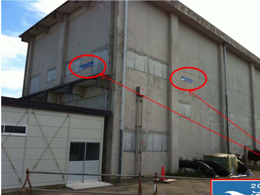
阿武隈川 荒浜排水機場への設置状況
