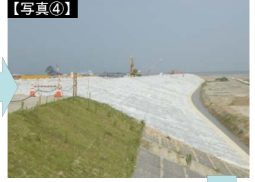
被覆ブロック(2t)設置完了状況
