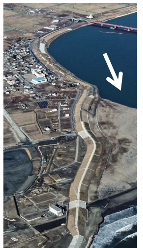
H29.1.10 （堤防整備工事中）
