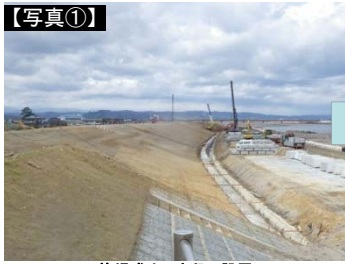
築堤盛土、法留工設置
