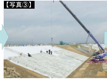
被覆ブロック(2t)設置
