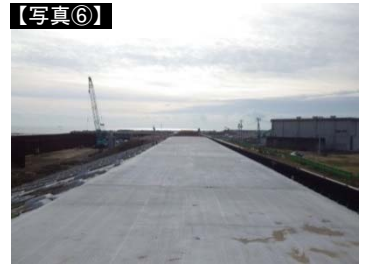
天端コンクリート打設完了状況
