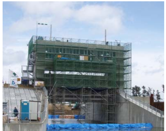
上屋・ゲート施工状況（H29.2.10撮影）
