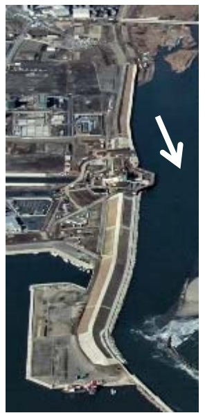
H29.1.10 （堤防整備工事中）
