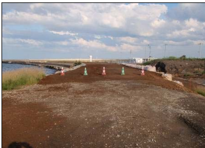
応急復旧完了 平成23年6月
