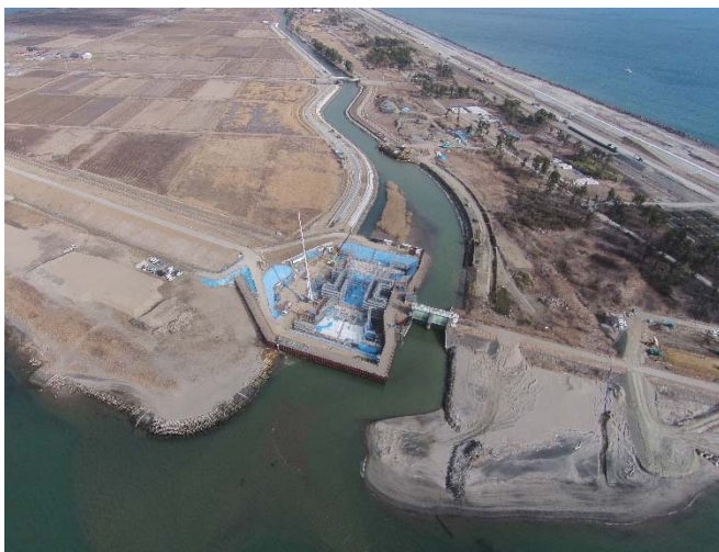
復旧状況（H28.2.11撮影）
