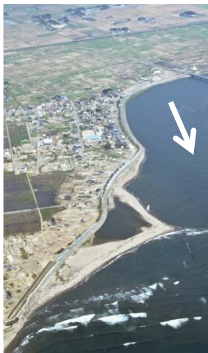
H23.7.26 （応急復旧完成）
