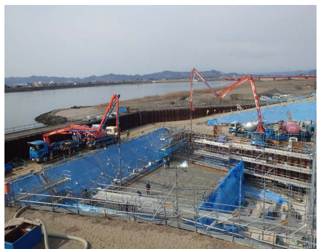
本体打設状況（H28.2.9撮影）
