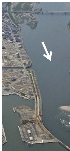
H23.5.26 （応急復旧完成）
