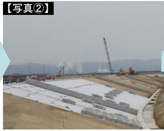
小口止工・隔壁工、遮水シート設置
