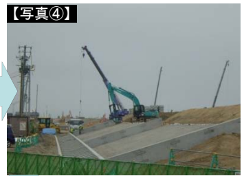
小口止工・隔壁工設置
