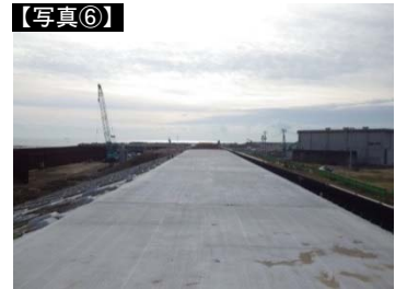
天端コンクリート打設完了状況
