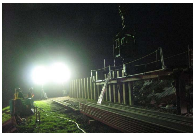
夜間における作業
