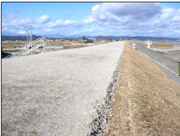
従前機能復旧後 平成24年12月
