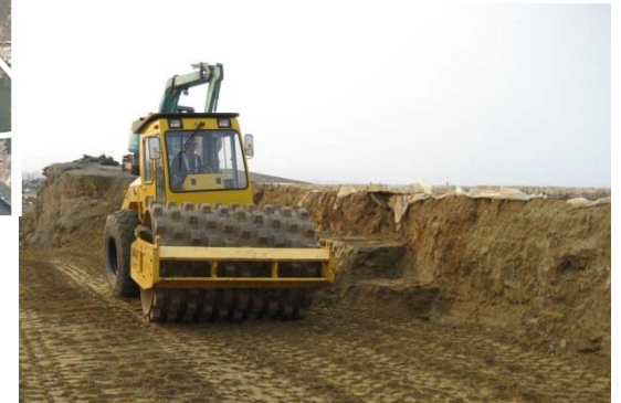
タンピングローラーによる締固め
