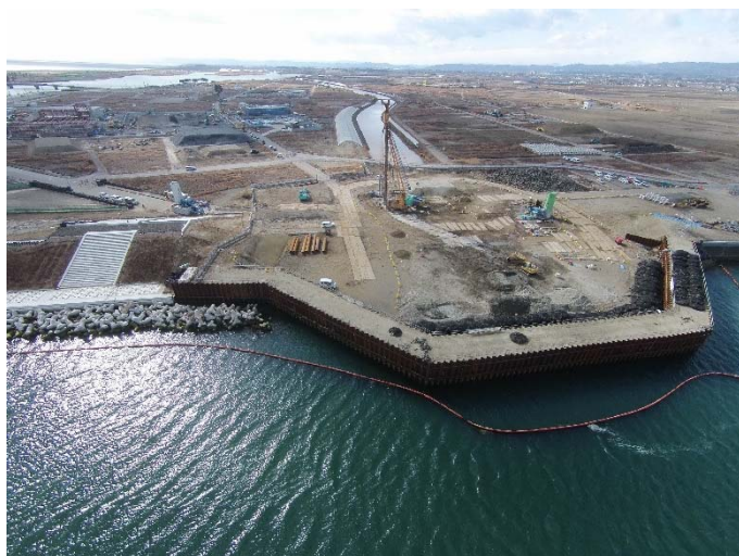
復旧状況（H28.2.11撮影）
