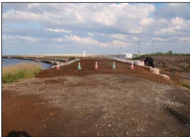
応急復旧完了 平成23年6月
