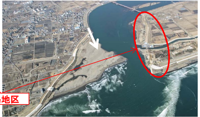
平成28年2月時点 復旧状況
