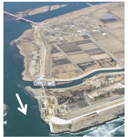
H28.2.12 (堤防整備工事中)
