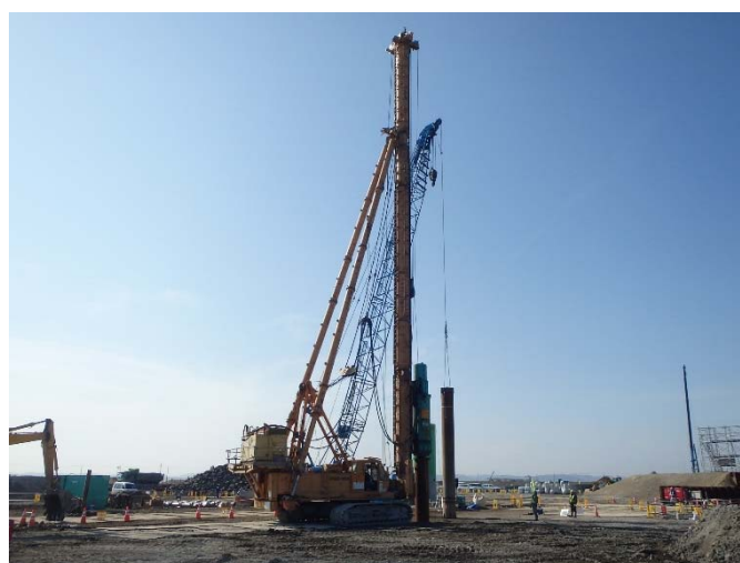
基礎杭施工状況（H28.2.15撮影）
