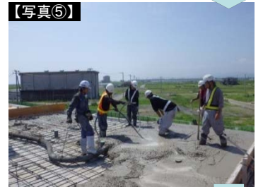
天端コンクリート打設 ※川裏被覆ブロック設置完了後
