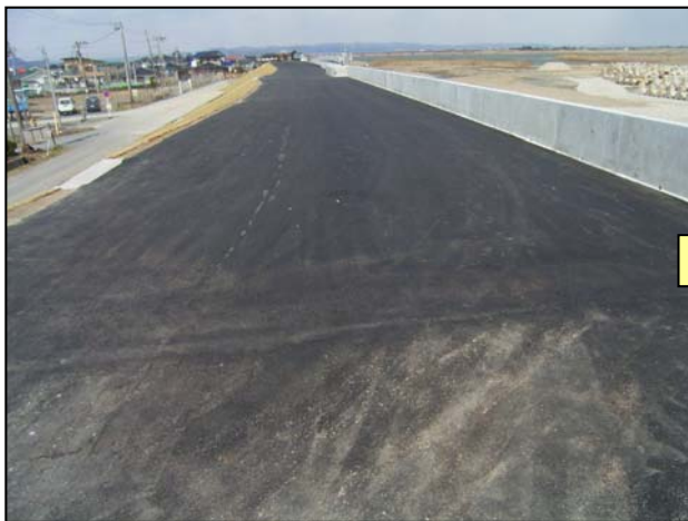
被災前(竣工時) 平成17年時点
