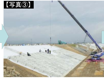
被覆ブロック(2t)設置
