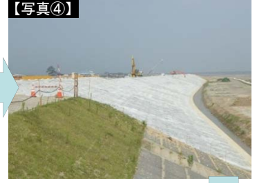
被覆ブロック(2t)設置完了状況
