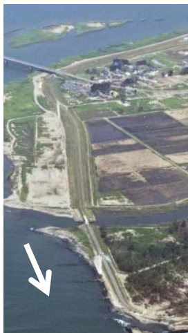
H23.7.26 (応急復旧完成)
