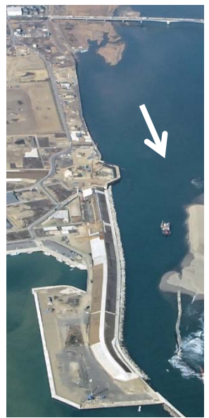
H28.2.12 （堤防整備工事中）
