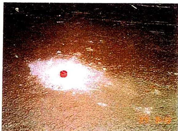
写真-22 設置後の状況
