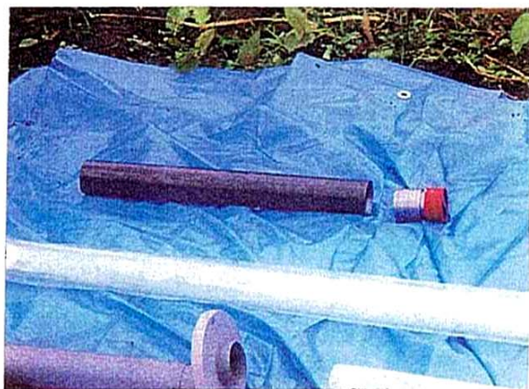
写真-21 鋼製保護管およびキャップ
