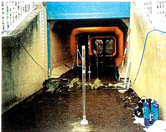
写真-19 アクリル製試験管の立ち上げ
