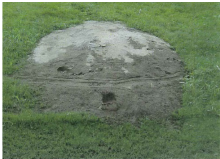
法面からの土砂 流出状況
