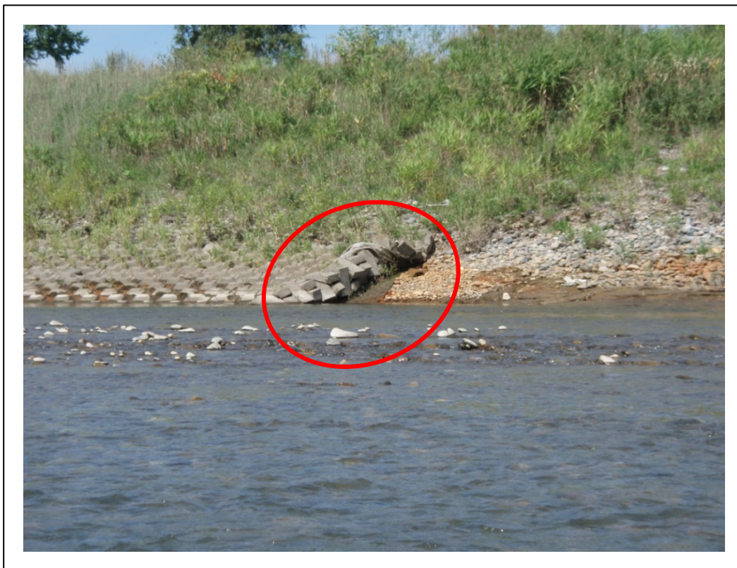
【部位欠損(法枠部)】
