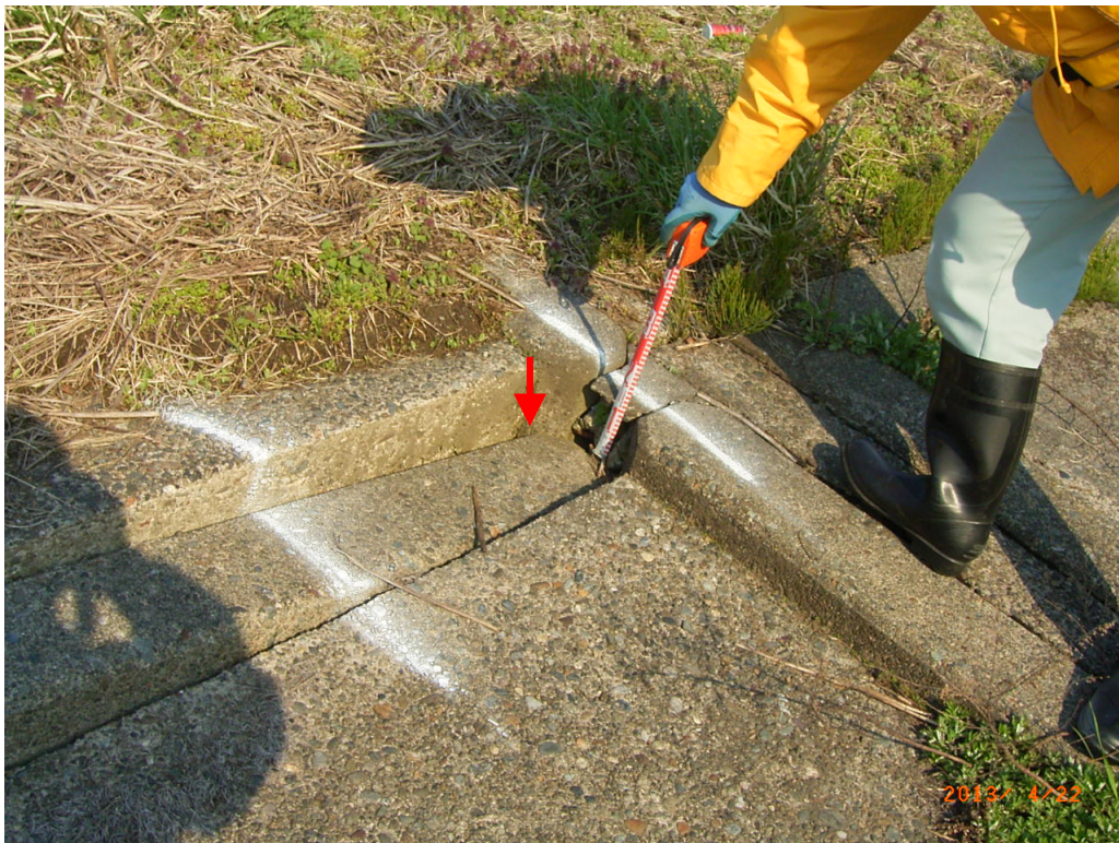
【格子枠の沈下状況】
