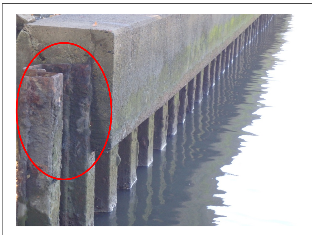
【矢板護岸の腐食状況】
