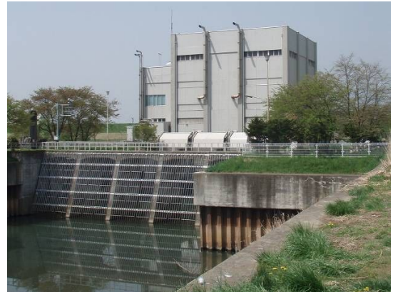
沈砂池・除塵機
