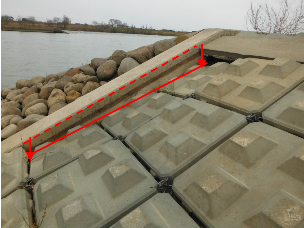
【格子枠の沈下状況】
