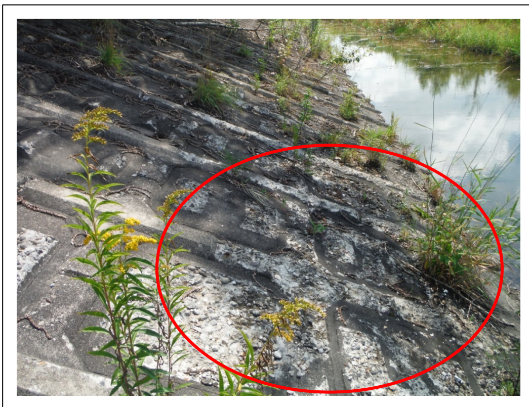
【部位欠損(法枠部)】
