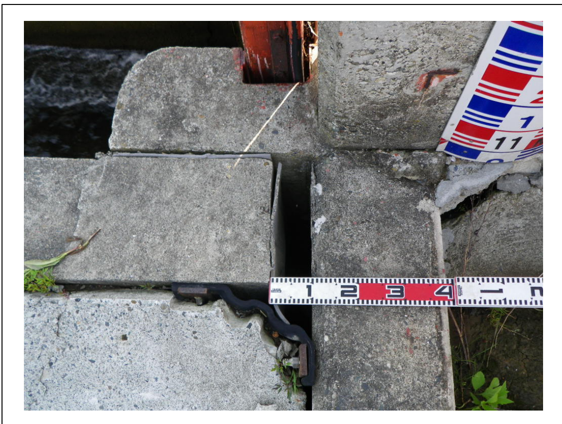
【胸壁と翼壁の継手の目開き】
