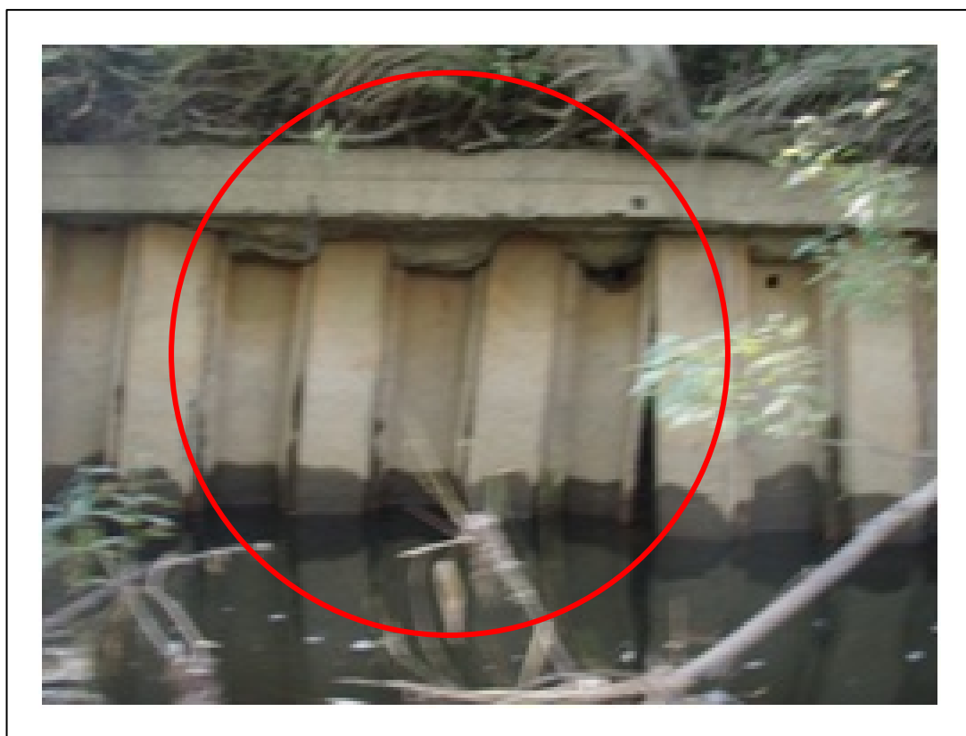
【矢板護岸の腐食状況】
