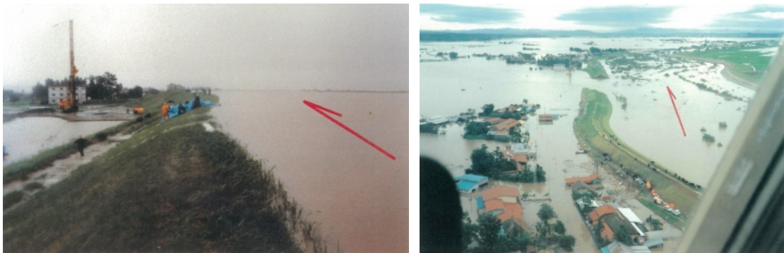
越水破堤の例（昭和61年8月 鳴瀬川水系吉田川）
