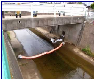
オイルフェンスの設置
