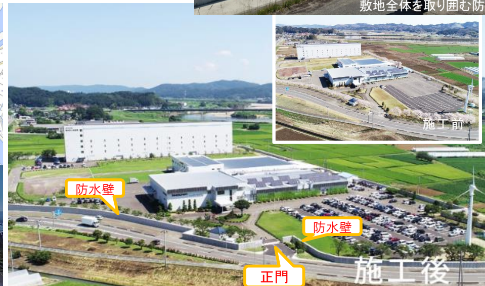
敷地全体を取り囲む防水壁
