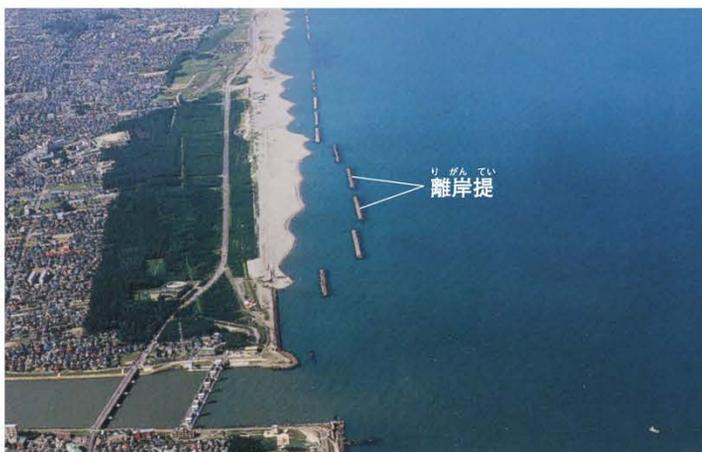
離岸堤や人工リーフの働きで、砂浜が回復しているのが見えます。
