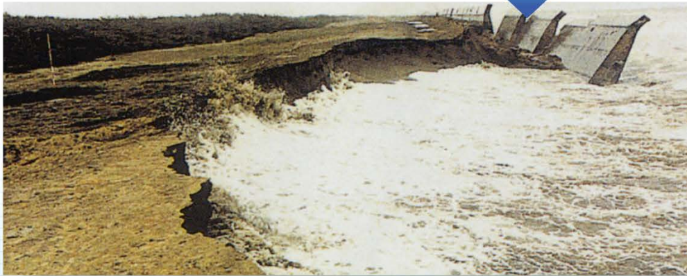
昭和54年に海岸堤防が被害を受けた。
