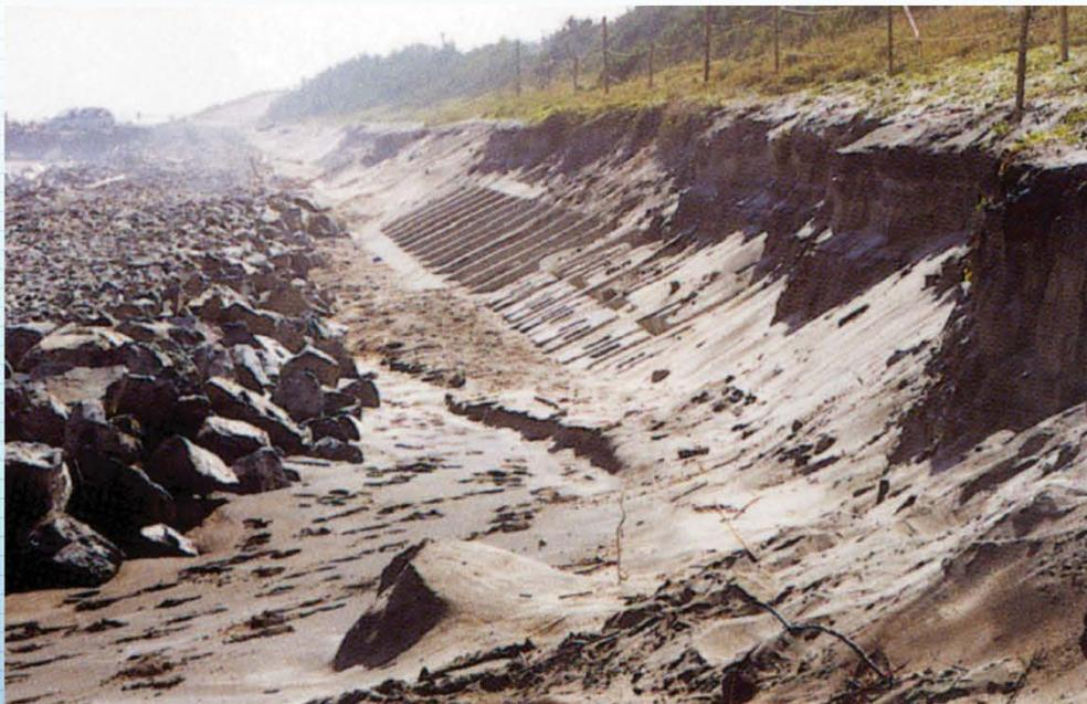
砂浜が波に浸食され、海岸堤防が被害を受けた。(平成11年撮影)
