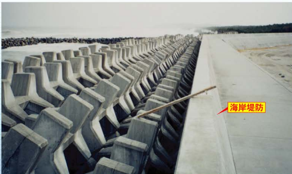
現在は、海岸堤防を守るため前面に消波ブロックが設置されている。
