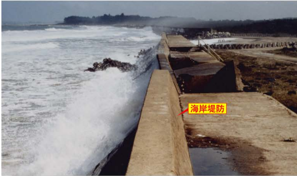
昭和58年、台風5号により海岸堤防が被害を受けた。
