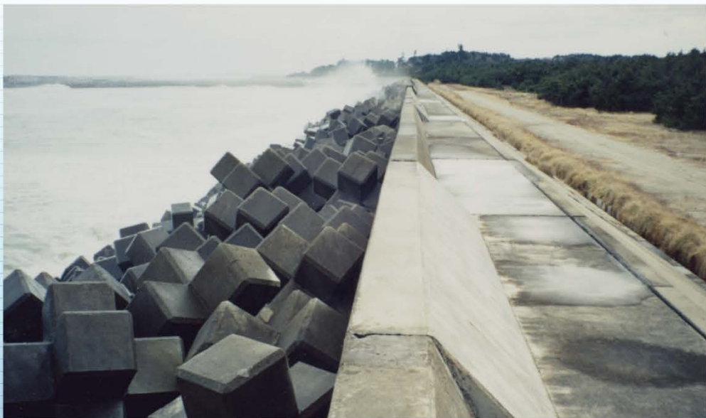
せっち 現在は、海岸堤防を守るため、消波ブロックが設置されている。
